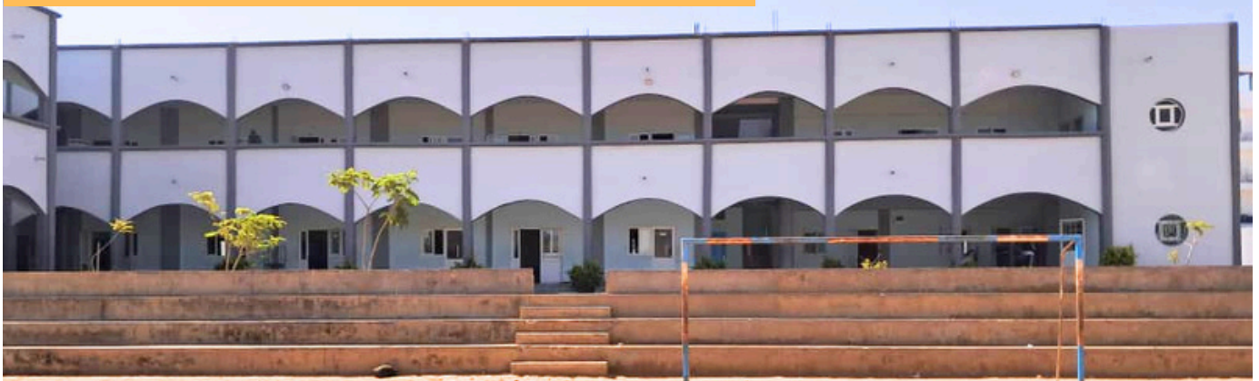
Construction-1er étage du Collège de Dakar
